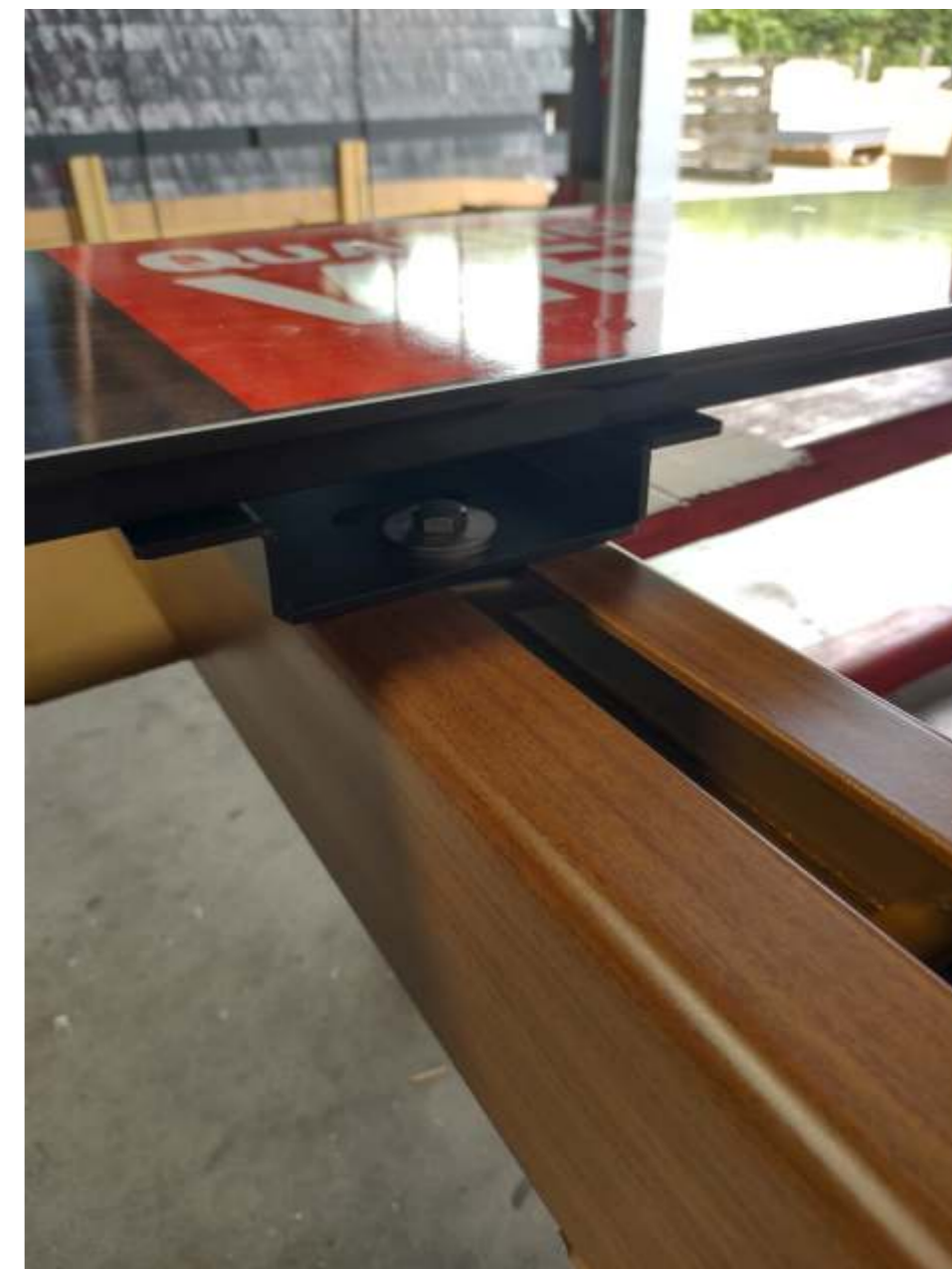
Principe de fixation des lattes et flèches
